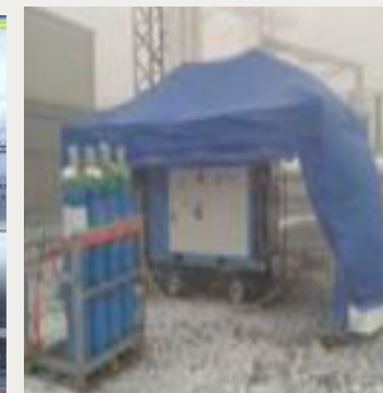
Рисунок 3 - обработка газа на втором проекте GIL 420 кВ в Килмарноке (Великобритания)
