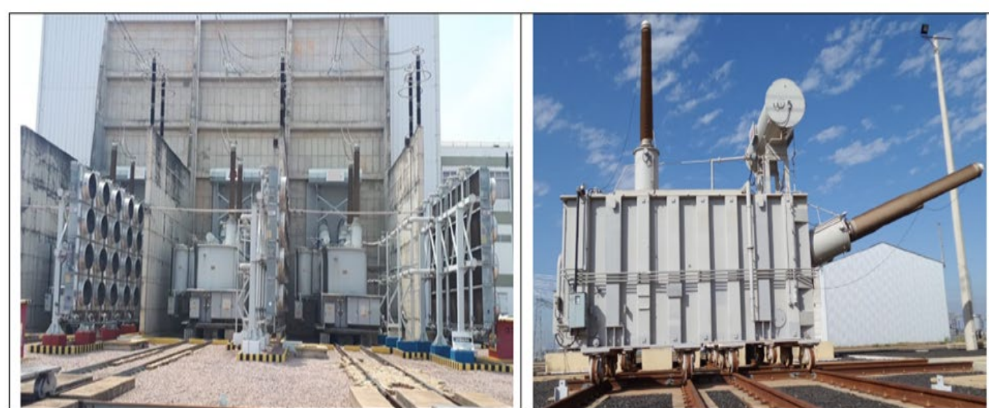
Рисунок 13 - Преобразовательные трансформаторов
