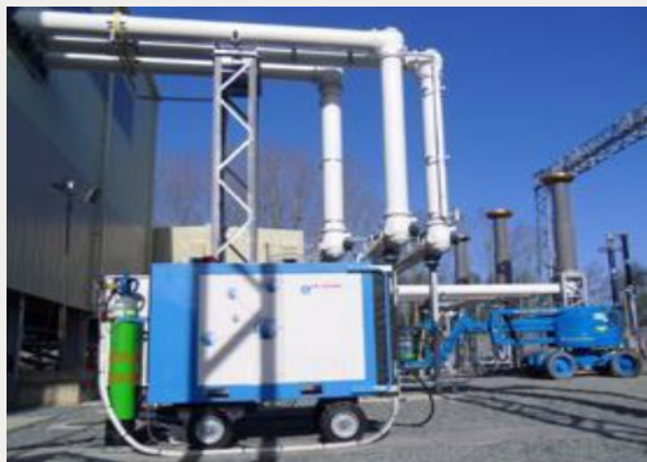
Рисунок 2 – обработка газа на первом проекте GIL 420 кВ в Селлиндже (Великобритания)
