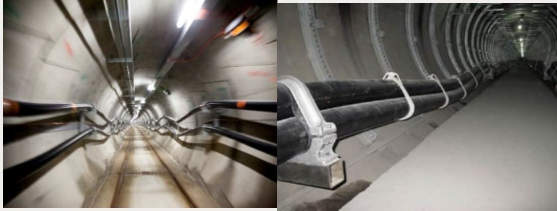
Рис. 9 - Кабели в туннеле Слева постоянный ток - справа переменный ток
