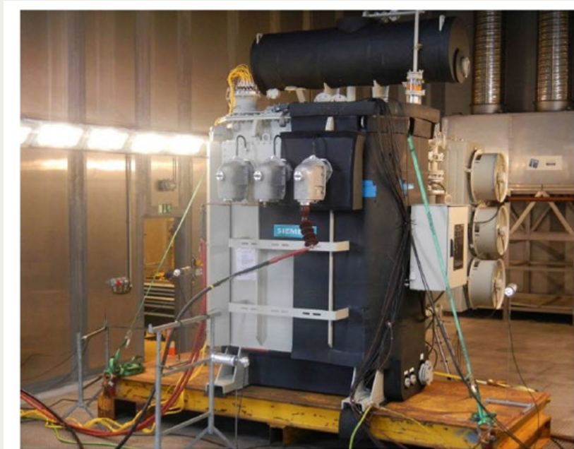
Рис.9 Испытательный трансформатор мощностью 15 МВА с использованием NE внутри климатической испытательной установки
