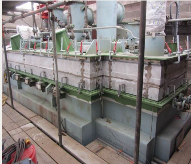
Рисунок 1: Мегалифт и щиты; переделка фланца верхней крышки, модификация и замена прокладки.
