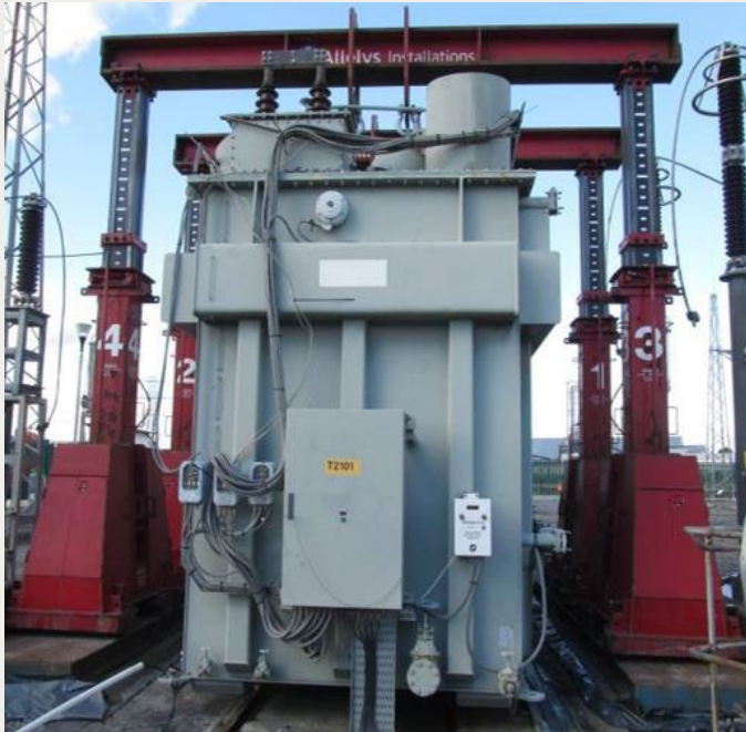
Рисунок 1: Мегалифт и щиты; переделка фланца верхней крышки, модификация и замена прокладки.
