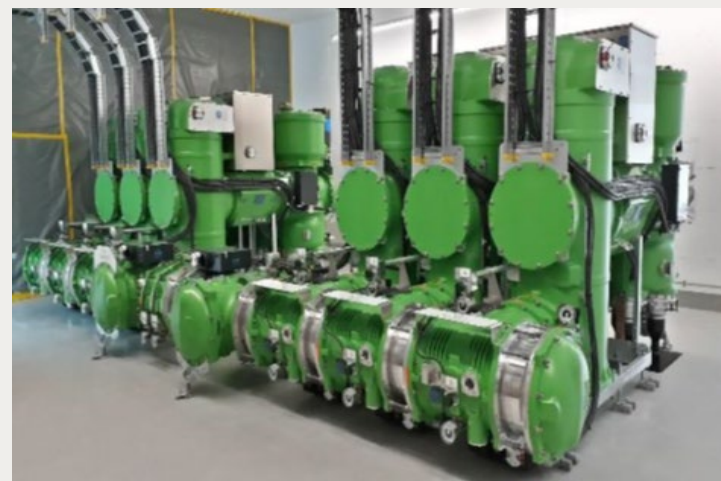
Рисунок 3 - обработка газа на втором проекте GIL 420 кВ в Килмарноке (Великобритания)
